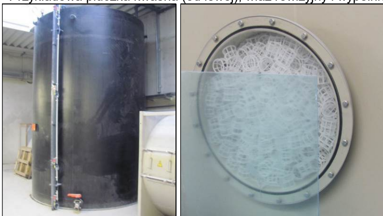
Rysunek 6.2 Przykładowa płuczka kwaśna (od lewej), włącz rewizyjny i wypełnienie (od prawej)
